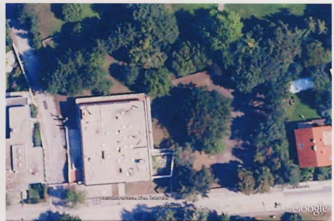
2) Hanselmayergasse 10-12: 3 Wohnhäuser statt einem Einfamilienhaus !! 10,5m Gebäudehöhe, statt 6m !! 3 Stockwerke statt 2 !!
