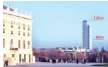
Tritt massiv neben dem Schloss Schönbrunn in Erscheinung: Der Komet-Turm soll nun endgültig nicht höher als 60 Meter werden – ursprünglich waren es 120. Foto: apa/WZ
